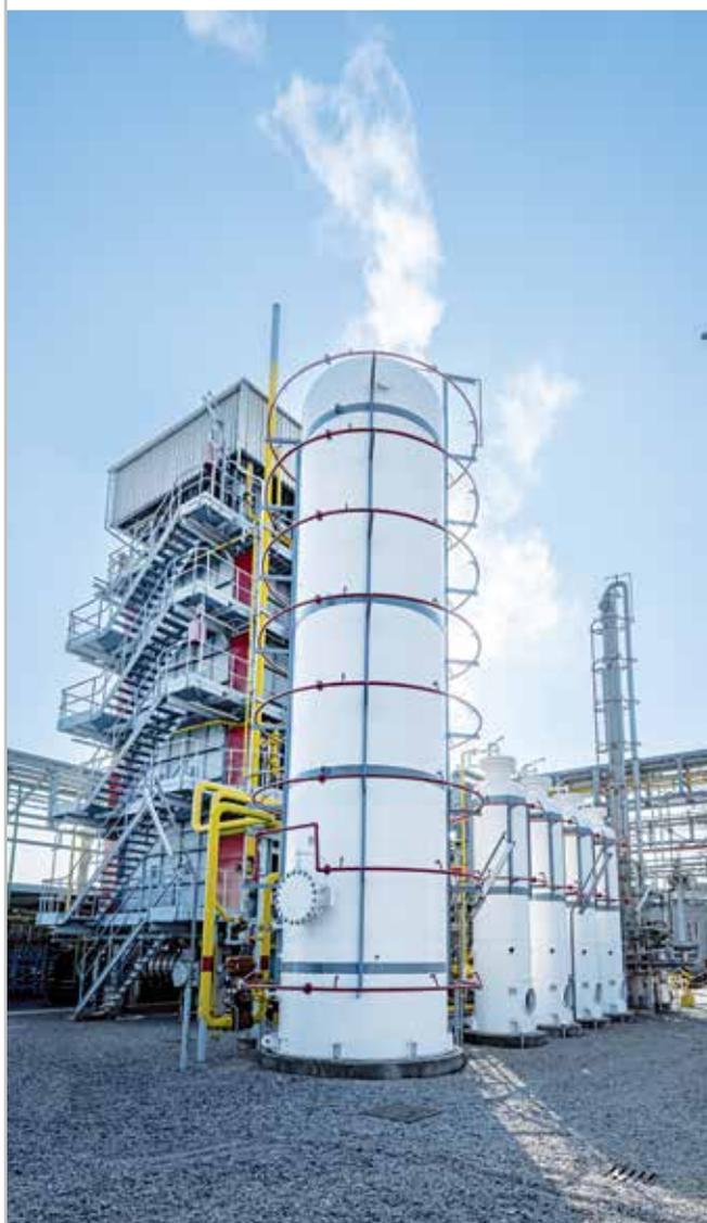
La produzione di idrogeno è basata sulla reazione tra metano e vapore d'acqua (Steam Reforming) in forno tubolare, alla temperatura di 800°C.
